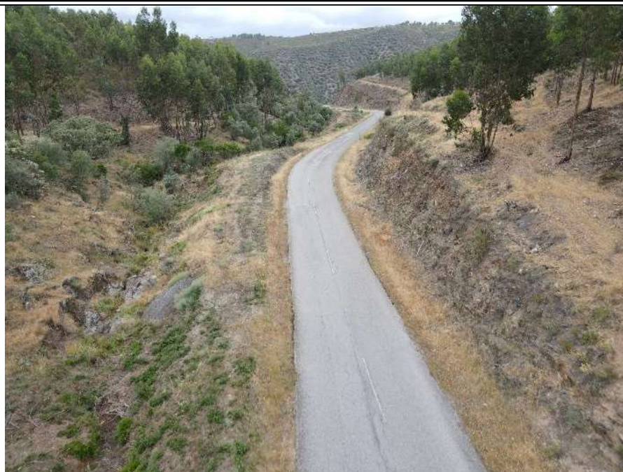
Figura 16 – Linha de água (sem classificação decimal) que corre paralelamente ao traçado aprox. entre o km 7+000 e o km 8+150 do lado esquerdo do traçado
