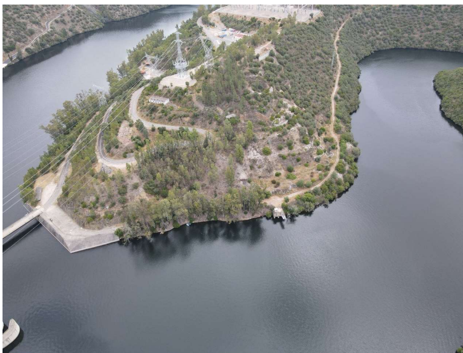
Figura 20 – Vista panorâmica do lado espanhol (Subestação de Cedilho e Linhas de Alta Tensão)
